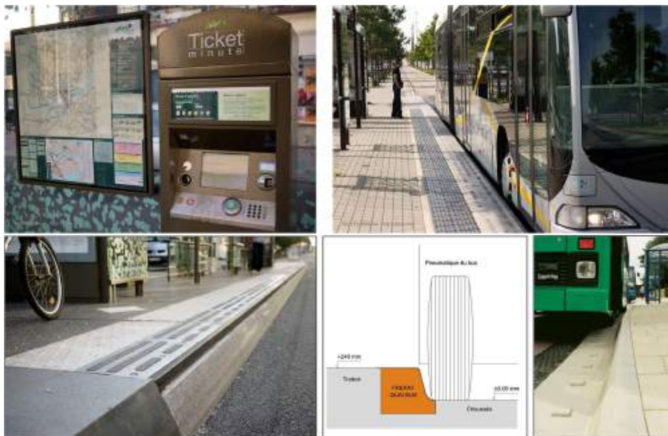
Figura 4-10 Allestimenti delle fermate BRT
